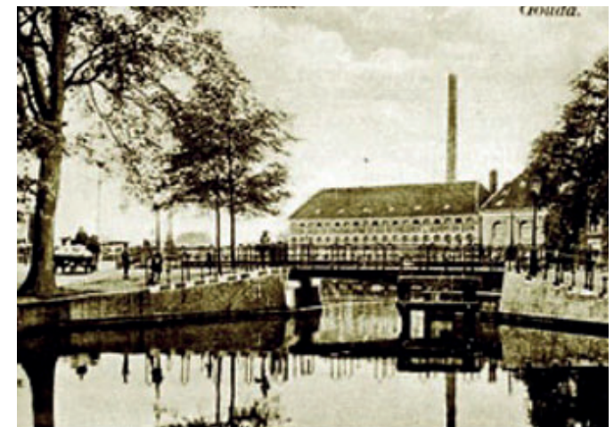
Regentessebrug in 1902 als ongelijkarmige draaibrug (Bruggenstrichting.nl)
