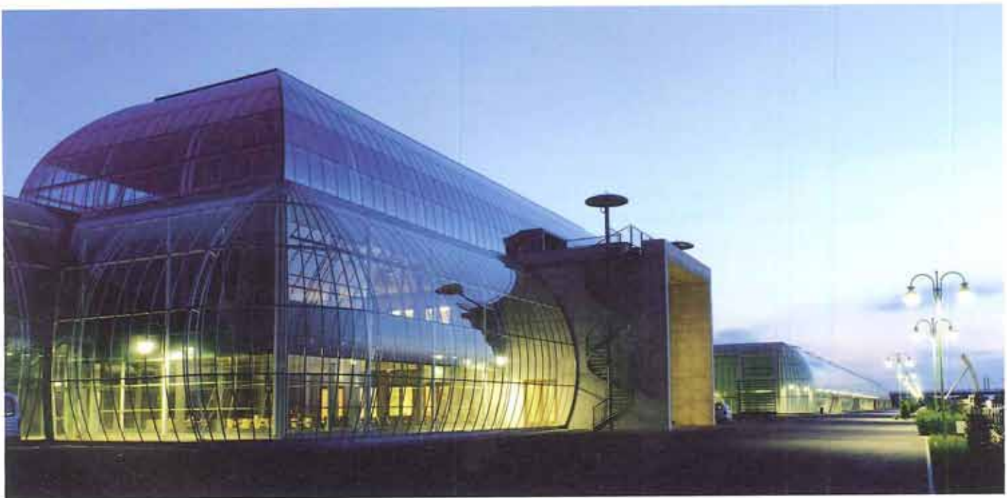
Het nieuwe kassencomplex van Anthura heeft een klassieke uitstraling met een statige, gekromde glaswand.
